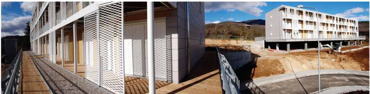
Photos_ nella serie di immagini a sinistra, fasi di cantiere a Roio Poggio - qui sopra, i due edifici di Tempera
